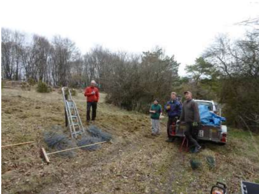
Abb. 10: Rückbau alter Zaunanlagen – März 2019
