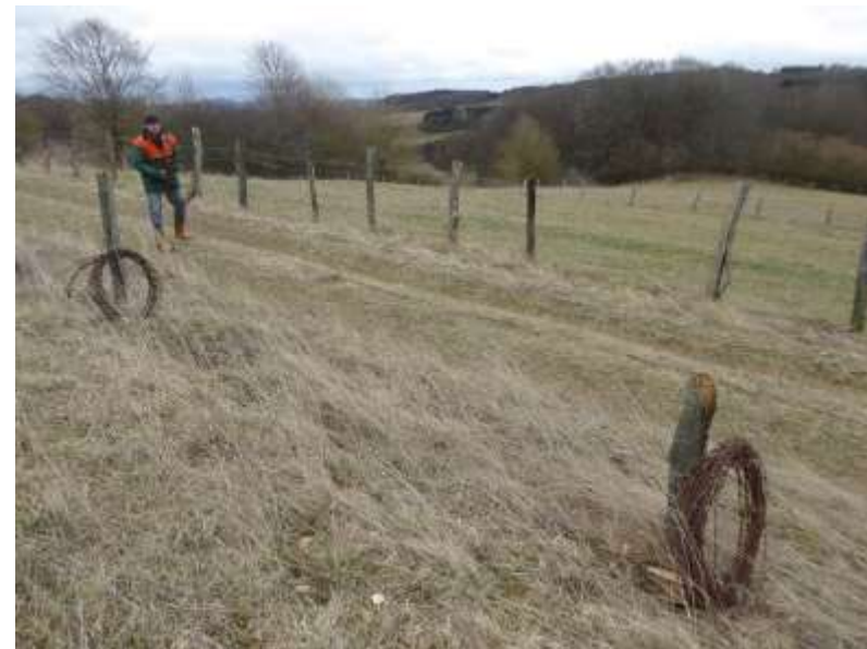
Abb. 8: Rückbau und Entsorgung von altem Stacheldraht – März 2019
